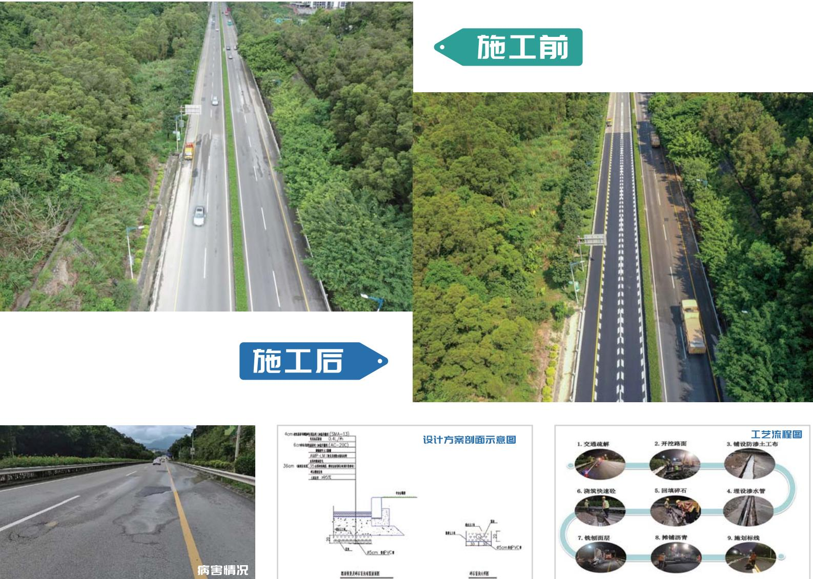
**解决措施：**为破解材料养生难题，路桥集团盐鹏深汕分公司通过多方面综合比选，最终确定采用2h快速混凝土浇筑，与传统施工材料相比，快速混凝土凝结硬化速度快，2小时即可达到标号强度，有效提高施工效率，缩减施工周期。经过连续加班加点施工，仅用5天有效工作时间圆满完成了盲沟铺设、病害处置的艰巨任务。
