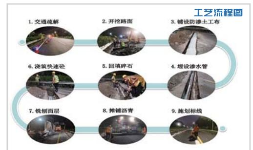
凝土3041平方米，施划高抗压超耐磨深标Ⅲ型热熔涂料标线242平方米，增设渗水管161米，浇筑快速混凝土17立方米，大大提升了路面观感与行车舒适度。
